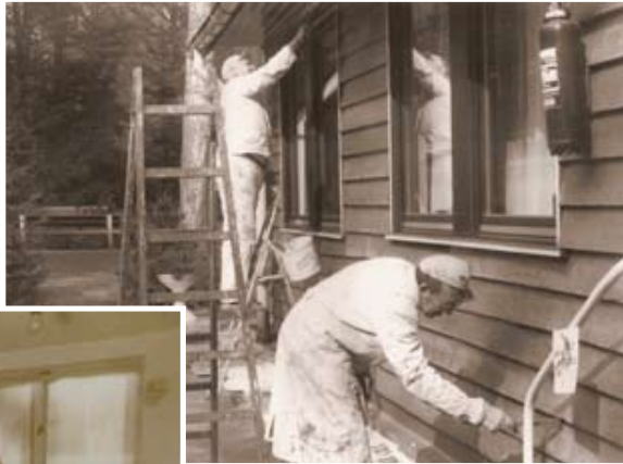
Renovierung des Wirtschaftsgebäudes 1978
